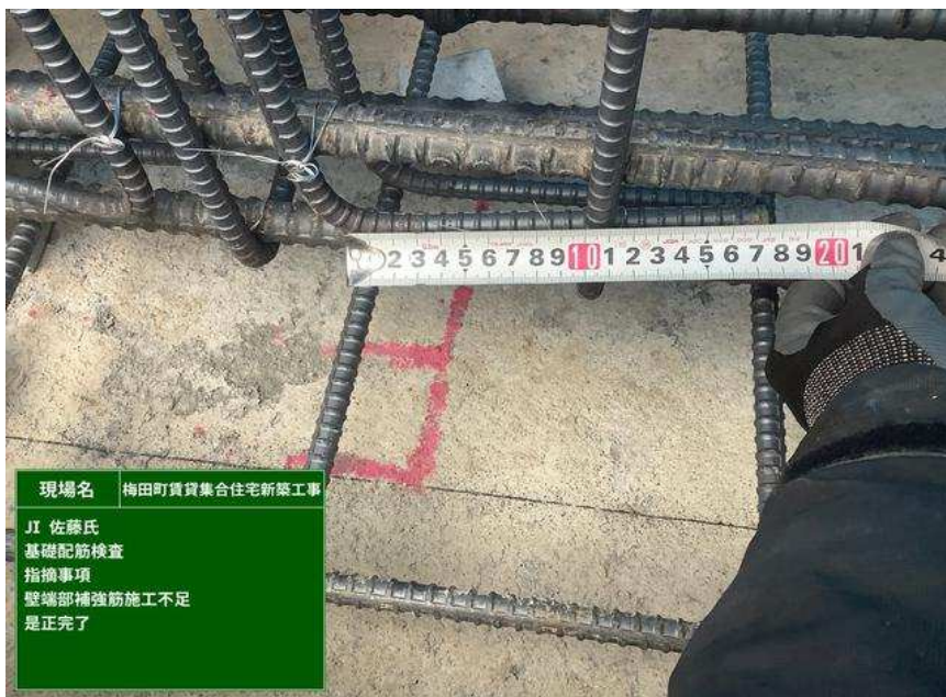
現場名 梅田町賃貸集合住宅新築工事 JI 佐藤氏 基礎配筋検査 指摘事項 壁端部補強筋施工不足 是正完了
